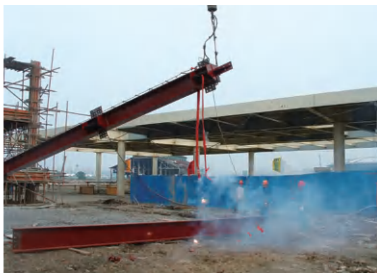
2009年·上海世博震旦馆上梁仪式
