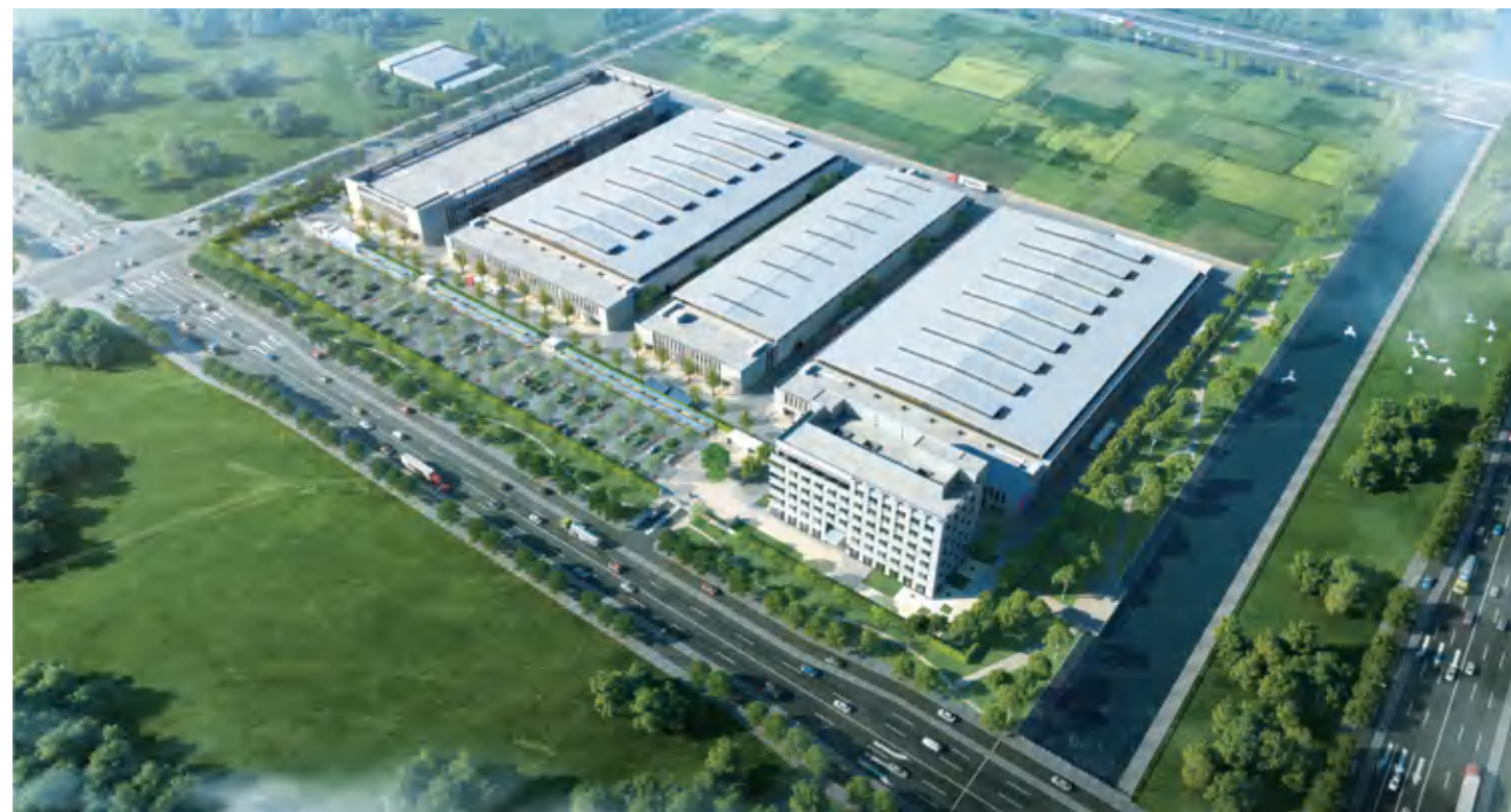
震旦江苏智能园区取得LEED金牌认证，实现绿色智能制造生产。
