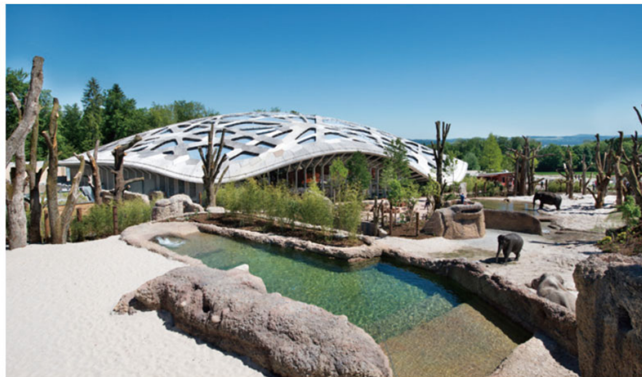
木建筑不只被用于住宅，也开始应用在公共建筑，瑞士苏黎世动物园的大象馆，便别出心裁使用大跨距的木构天幕，为象群营造充满自然气息的生活环境。
