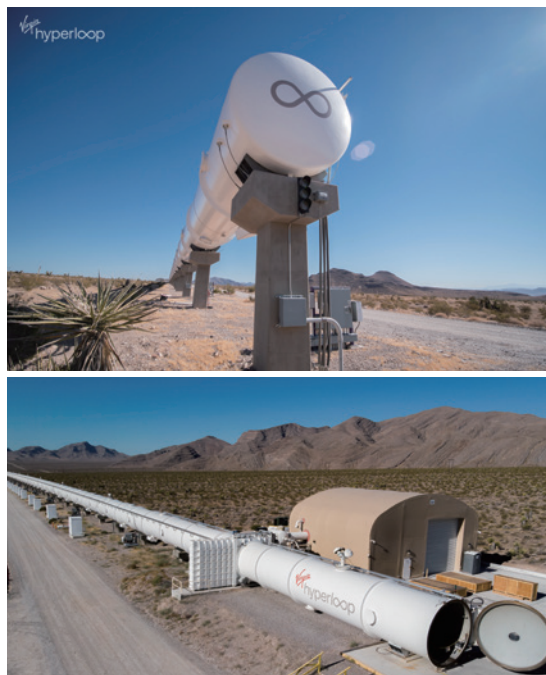
“维珍超回路”测试场实景
