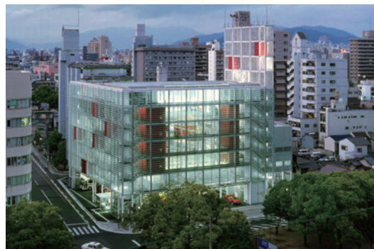
西广岛消防站，整幢建筑立面、墙面、楼面都由强化玻璃板构成，呈现极度通透的特性。
