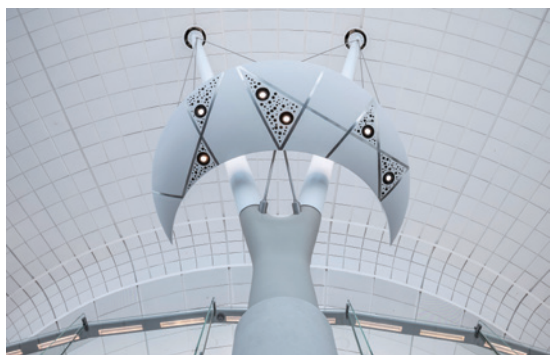
Y型结构柱与弯月造型照明装置。
