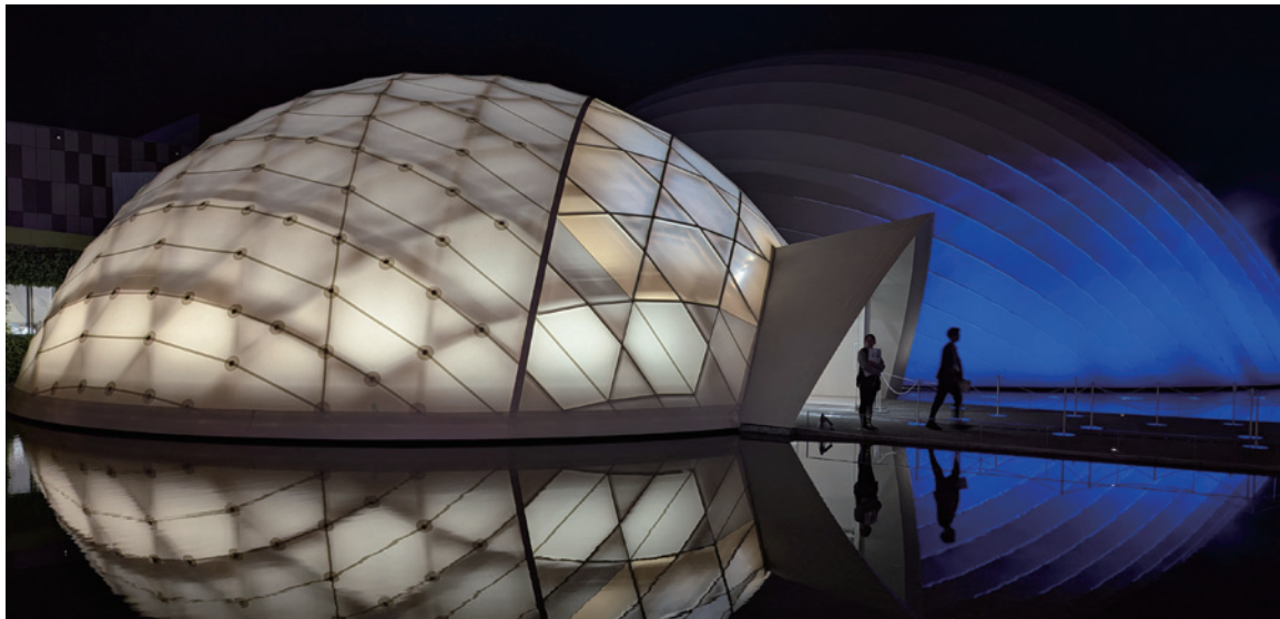
坂茂与原研哉合作的“蓝色海洋圆顶”展馆，以竹材、回收纸管、强化碳纤维打造出三座巨大的拱顶建筑。
