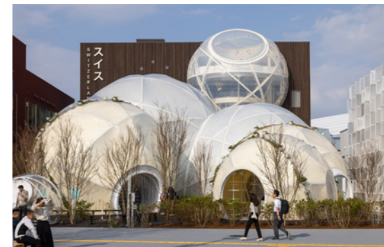
04 宛如大温室的球状造型，由轻量金属结构将聚合物塑料薄膜撑起。
