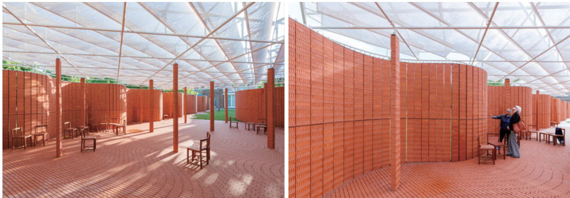
左：透光的屋顶让阳光空气于空间中自在流动，模糊了建筑室内外界线。右：展馆建筑尽管轻巧，但墙体的稳定得自于曲面造型所带来的结构。
