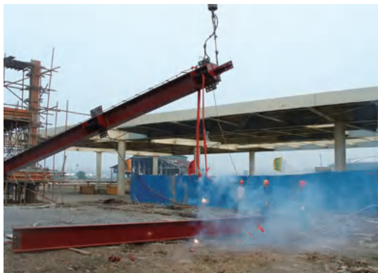
2009年·上海世博震旦馆上梁仪式
